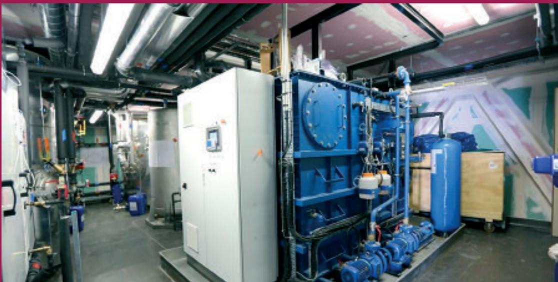
A sinistra, in bianco, l'unità di trattamento dell'aria nel locale tecnico al piano terra; in blu, la macchina di cogenerazione a olio di colza.
