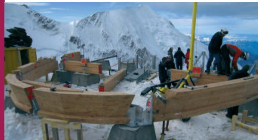
A sinistra, due fasi della realizzazione del solaio contro terra. Nell'immagine a lato, la posa delle travi di bordo in legno lamellare sulle fondazioni in c.a.; in basso, si procede con la realizzazione del solaio vero e proprio. Qui sotto, il rifugio in una fase avanzata dei lavori; si stanno posando i moduli fotovoltaici in copertura.
